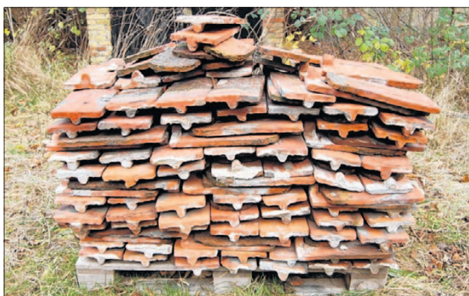
Alte Tonziegel – im Zuge der Sicherungsarbeiten vom Dachstuhl des Gutshauses genommen – warten gut sortiert auf ihr Comeback.
