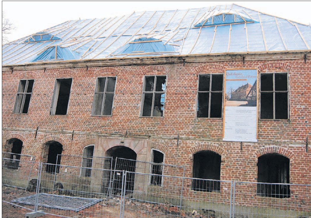
Der wesentlichste Teil der Sicherungsarbeiten am ehemaligen Gutshaus Lancken umfasst die Entlastung des Dachstuhls sowie das Verschließen des Daches mit Regenschutzplanen. Fotos (3): R. Nestmann
